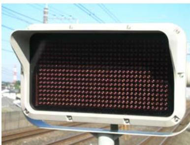
ATOS の一種である出発時期表示機。列車のダイヤが狂った場合、ここに変更された出発時刻が表示される。運転士が停車中に運転席から見えるホームの先端と、車掌から見えるホームの最後尾に設置されている。
